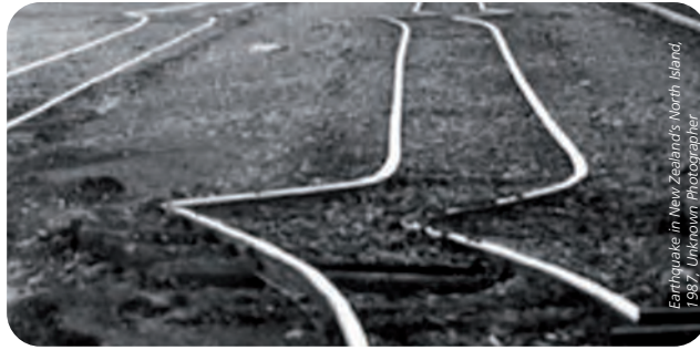
Gleisversatz nach einem Erdbeben
